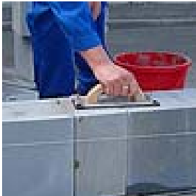
Выравнивание поверхно- сти шлифовальной доской
