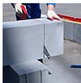
Распиливание блока руч- ной пилой
