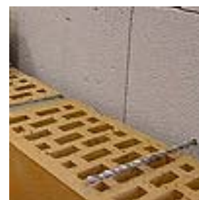
Крепление облицовки из кирпичной кладки
