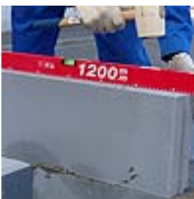
Проверка горизонтально- сти кладки строительным уровнем
